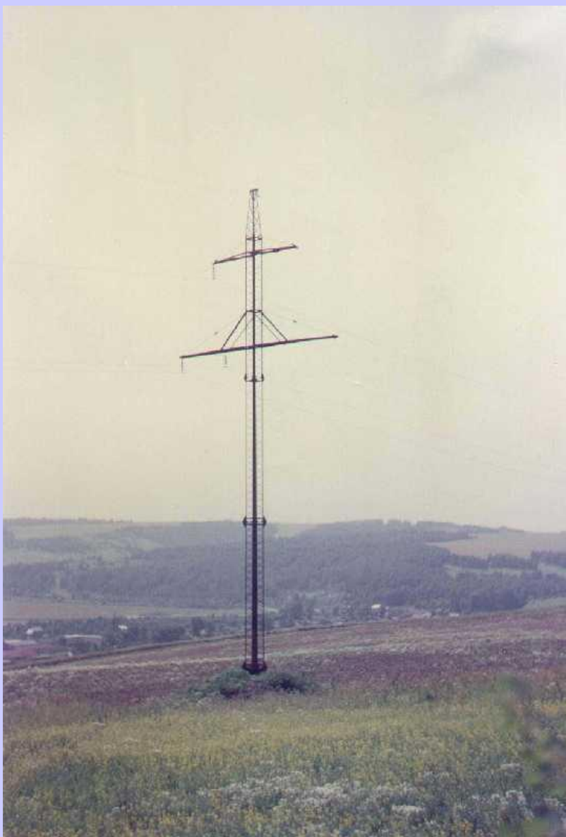
Двухцепная ВЛ 35 кВ в режиме одной смонтированной цепи (ЮЭС ОАО «Кузбассэнерго»)
